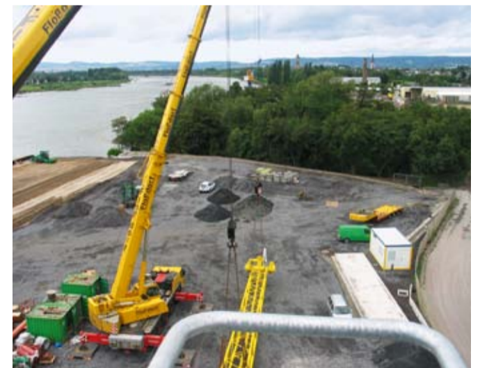
Hafen Bendorf – Baustelle der hochwasserfreien Lagerfläche
